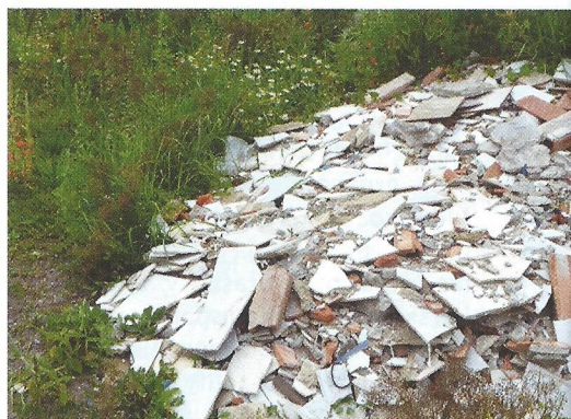
W miejscu po budowie przede wszystkim usuwamy zalegające jeszcze w ziemi resztki materiałów budowlanych
